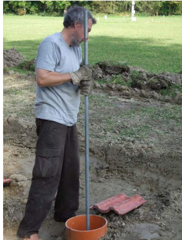
Abb. 13: Lagenweises Verdichten des Sandes
