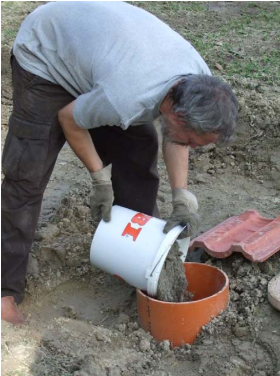
Abb. 12: Lagenweises Einfüllen des Sandes
