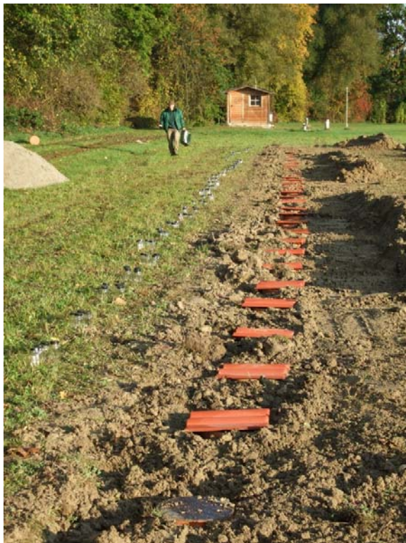
Abb. 3: In Graben eingebaute Rohre, zum Schutz vor Niederschlägen vor dem Versuch abgedeckt
