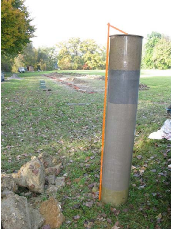
Abb. 10: Fertige Mustersäule; im Hintergrund das Testfeld
